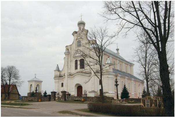
Jūžintų Šv. arkangelo Mykolo bažnyčia
