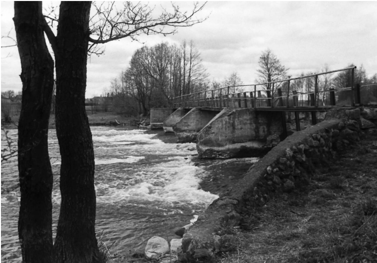
Malūno užtvanka padėjusi Šventosios vandenį nukreipti link malūno. V. Juknio nuotrauka
