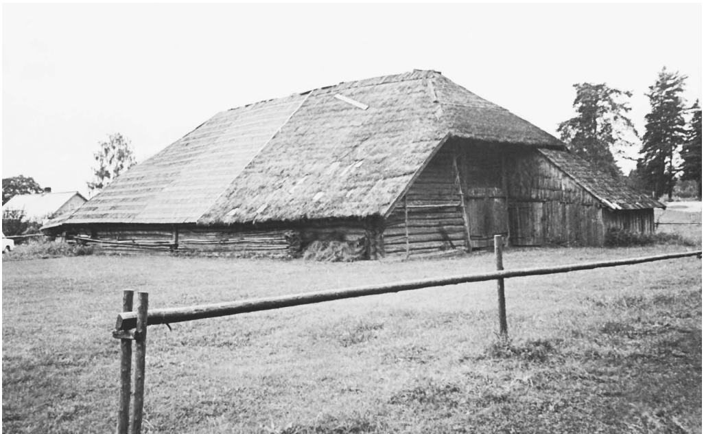
Jono Vaišnoro kluonas. Stogas dengtas skiedromis. Šeimatis k. A. Petrašiūno nuotr. 1977 m. Iš aut. archyvo
