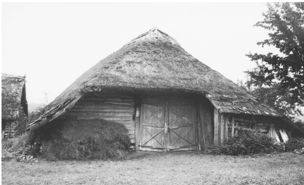
Vinco Biveinio kluonas (klojimas). Stogas dengtas šiaudais, vėliau lopytas skiedromis. Meldutiškio k. A. Petrašiūno nuotr. 1977 m. Iš aut. archyvo
