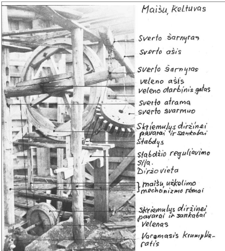
12 pav. Maišų užkėlimo mechanizmas
