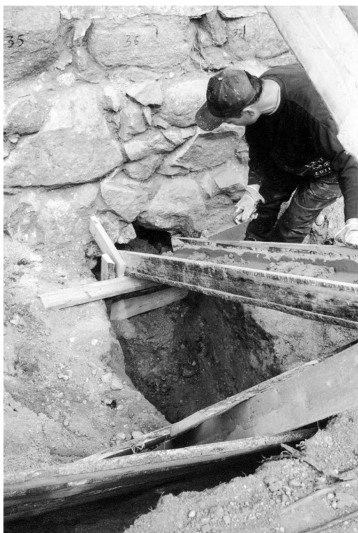
Tvirtinami atkasti bažnyčios pamatai. 2003 m. O. Fedajjevo nuotr.
