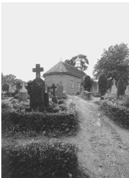
23 pav. Laukuvos kapinių sklypas Nr. 270 (žr. 3 pav.) ir koplyčia, statyta XVIII amžiuje. 1979 m. ji įregistruota kaip architektūros paminklas 34 . Koplyčia stovi kapinių centre, priekinis fasadas atgręžtas į kapinių vartus pietvakarių pusėje. Tai stačiakampis iš medinių sienojų suręstas pastatas. Fasadai apkalti vertikaliomis lentelėmis ir nudažyti. Stogas dvišlaitis, dengtas skiedromis. Virš pagrindinio įėjimo yra nedidelis skarda dengtas bokštelis. 2001 m. V. Karvelytės-Balbierienės nuotr.
