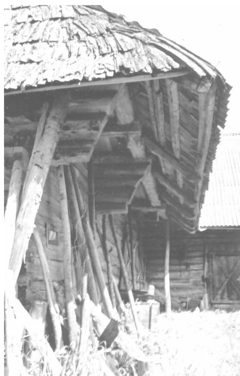
45 pav. Sodybos Nr. 28 daržinės stogo konstrukcijos fragmentas. 2001 m. V. Karvelytės- Balbierienės nuotr.
