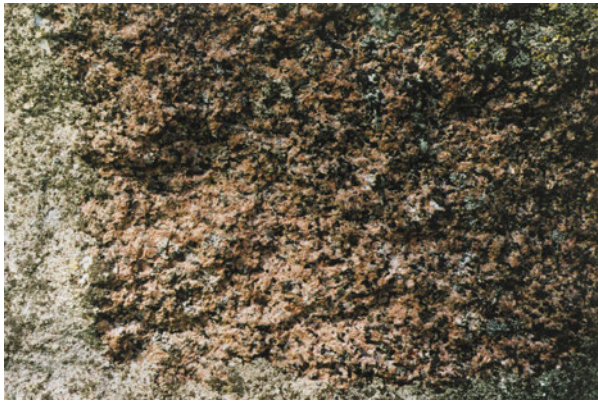
47 pav. Gneisas. 47 statinys. 158 blokelis. Matomas plotis – 28 cm. Kairėje matyti cementas
