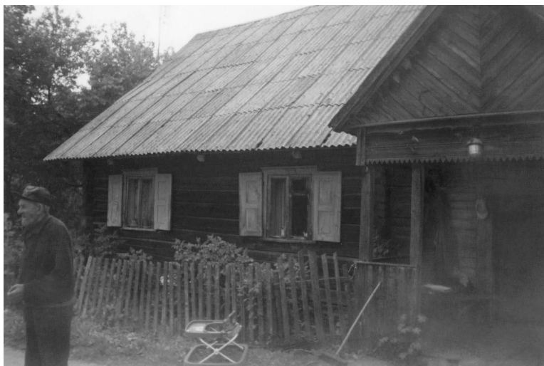
4 pav. Broniaus Kudelio gyvenamasis namas su prieangiu Karališkių kaime. Statytas XIX a. pab., remontuotas 1903 m.: a) priekinis fasadas; b) šoninis fasadas iš kiemo pusės; c) galinis fasadas
