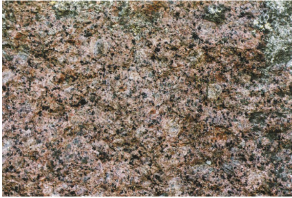
44 pav. Alandų rapakivis. 12 statinys. 38 blokelis. Matomas plotis – 30 cm. Dešinėje, kampe, matyti cemento likutis
