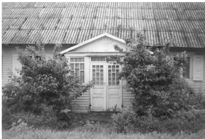
13 pav. Savarauskų gyvenamasis namas Mančiušėnų kaime: a) šoninis fasadas; b) galinis fasadas; c) dekoro detalė
