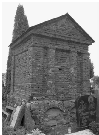
Laidojimo koplyčia (XIX a.) Gelvonų kapinėse. 2008 m. V. Girininkienės nuotr.
