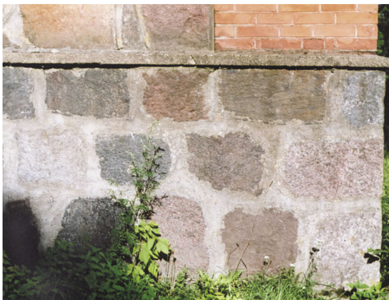
37 pav. Gelvonų bažnyčios šventoriuje esančios koplyčios lauko pusėje, sienoje, kyšo dubeniuotas sugneisintas akmuo
