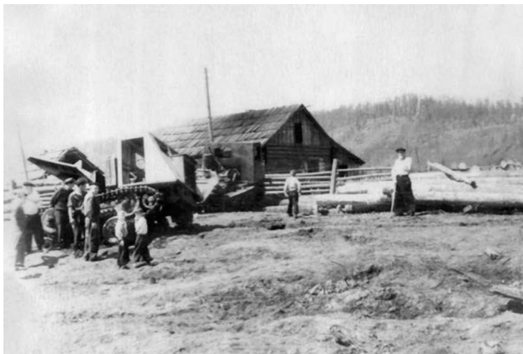
Anastasio k.: medžių kamienų tralavimo traktoriui TDT-40 dedamas nukritęs vikšras. 1957 m. Iš A. Bajerčiaus asm. albumo
