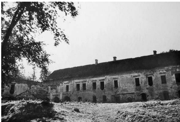
Gelgaudų piliis iš kiemo pusės (šiaurinė dalis). Iš LKPMCA fondų
